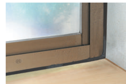
因鋁窗結露而造成潮濕的窗框與壁面
