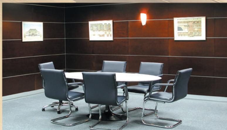
**南亞矽酸鈣化粧板** 基材採具優異防火耐燃性能的矽酸鈣板，表面再經裝飾加工處理，除針對防火耐燃性能做出確保改善外，更進一步將現有木工裝修的習慣納入，是一個真正符合新世代綠建材概念之防火裝潢材。
