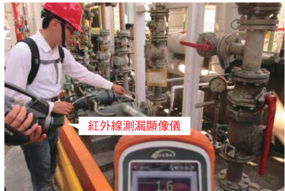
廠內定期執行設備元件洩漏源自主檢測作業
