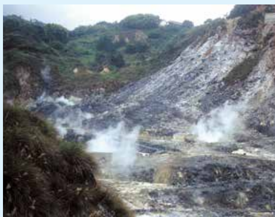
溫泉配管 Hot Spring piping
