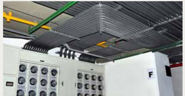
電導管工程 Electrical engineering
