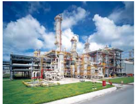
石化工廠 Petrochemical plant
