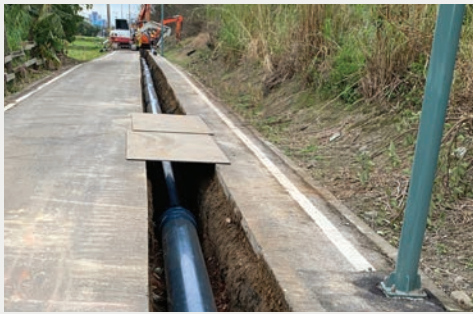
自來水管路工程
