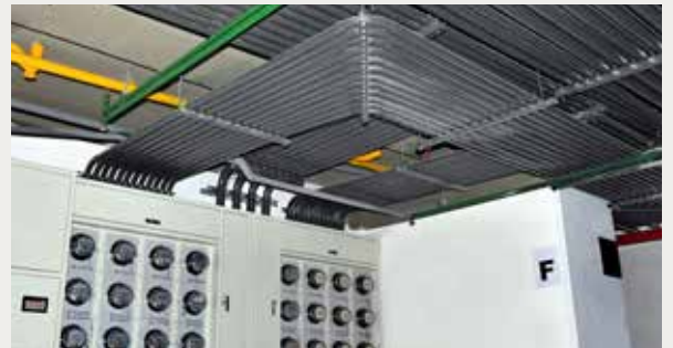
電導管工程 Electrical engineering
