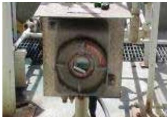
廠內製程區設置8,109個氣體偵測器，異常時立即通知並加以處理，源頭管制洩漏問題。
