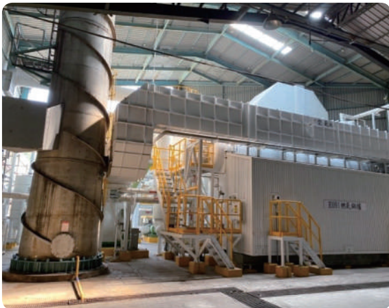
樹林燃氣鍋爐廠房外觀
