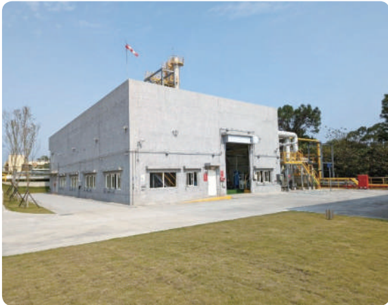
林口燃氣鍋爐廠房外觀
