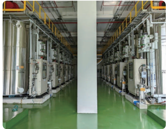
廠房內部照片
